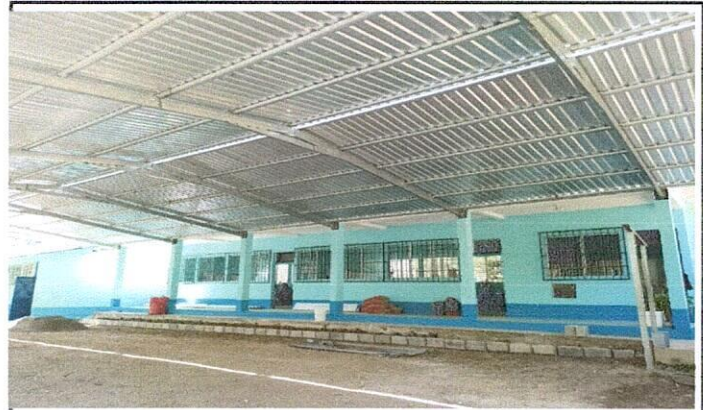
Foto 2: Avance del mejoramiento de piso
