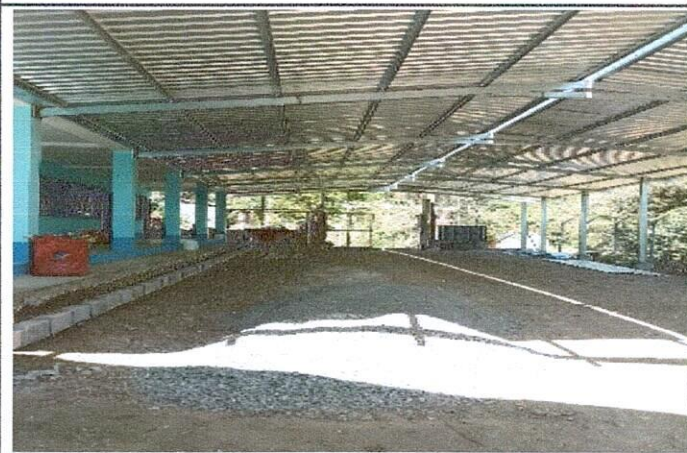
Foto 3: avance del mejoramiento del techo de patio
