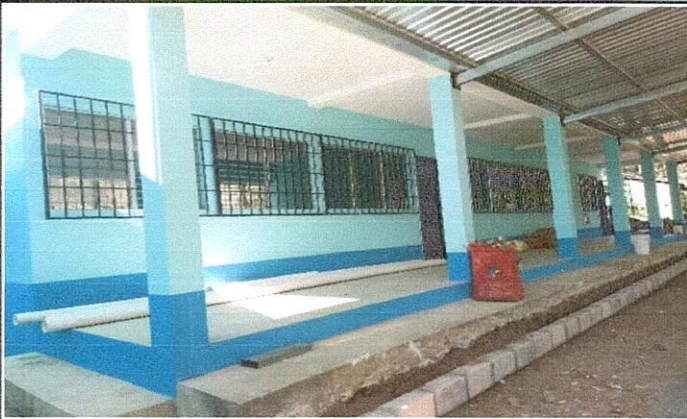
Foto 1: Avance de la reparación de Cubierta de lámina
